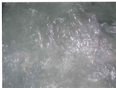
剥離した後のシート
